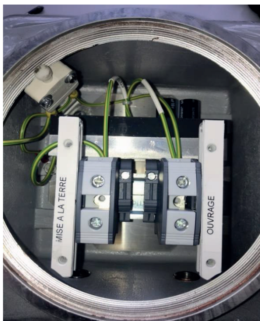
Câblage Cellule BCC ATEX monocâble (réf. E101894)
